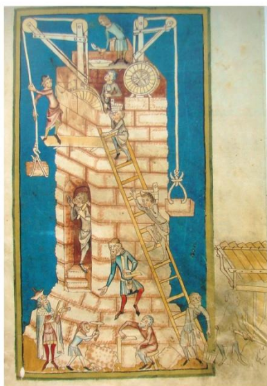
Afb 2 Hijswerktuigen bij de bouw van een toren 24
